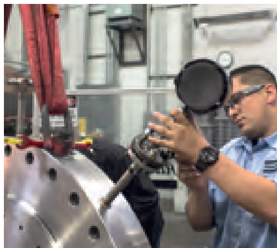
透平膨胀机组装后进行水压测试。
